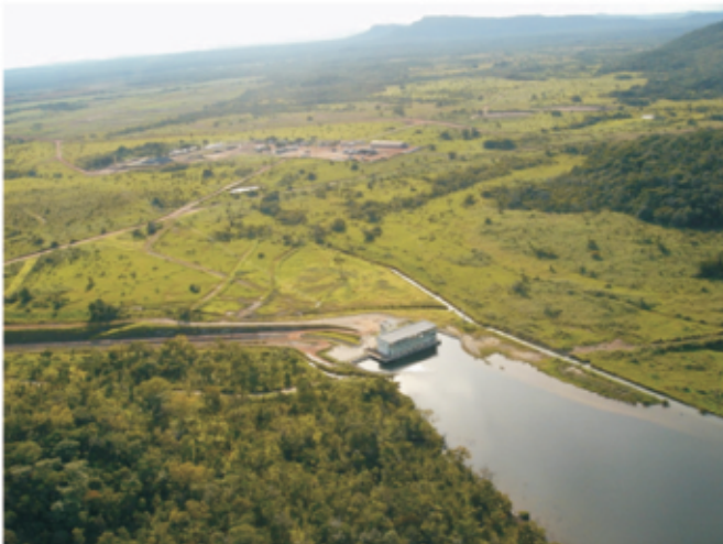
Figura 26 - Vista Aérea da Barragem Manuel Alves.
